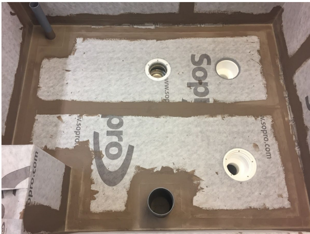
Provlådan färdig för provning
