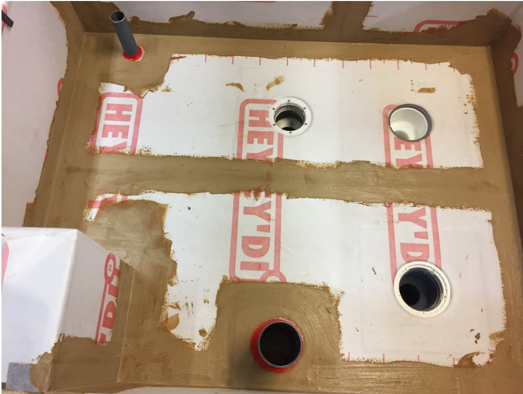
Provlådan färdig för provning
