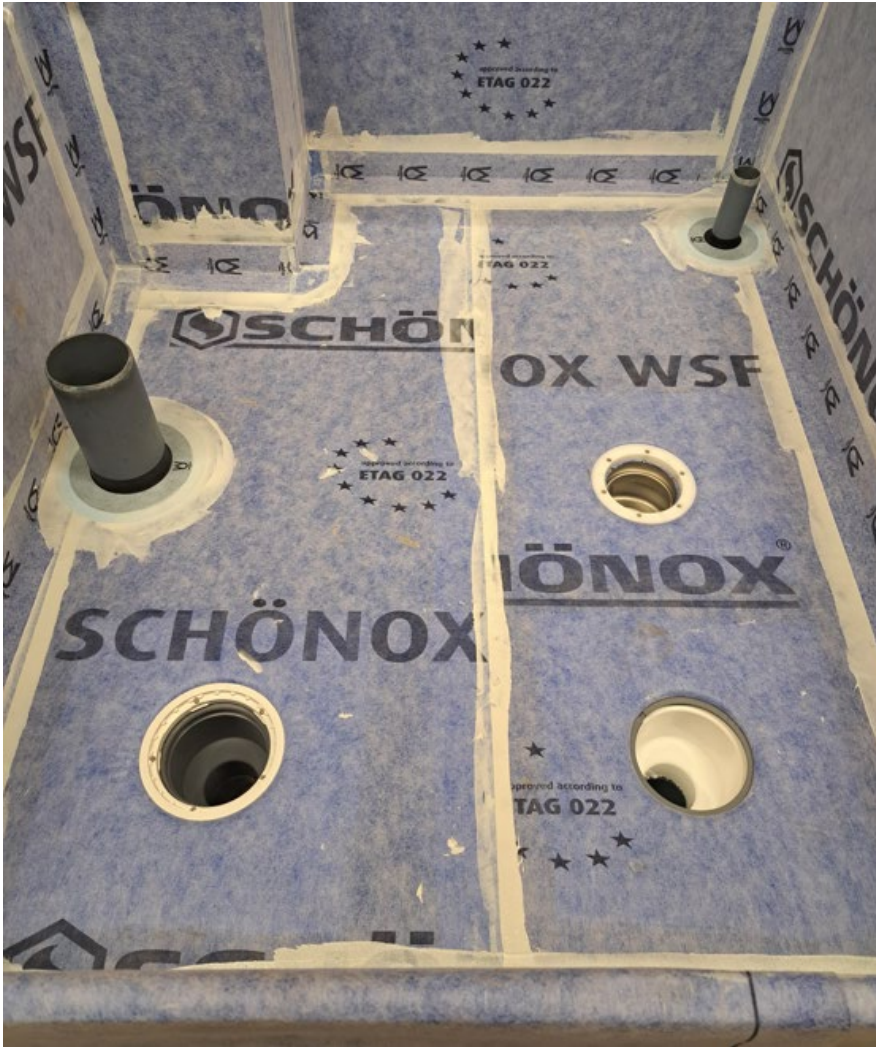
Provlådan färdig för provning
