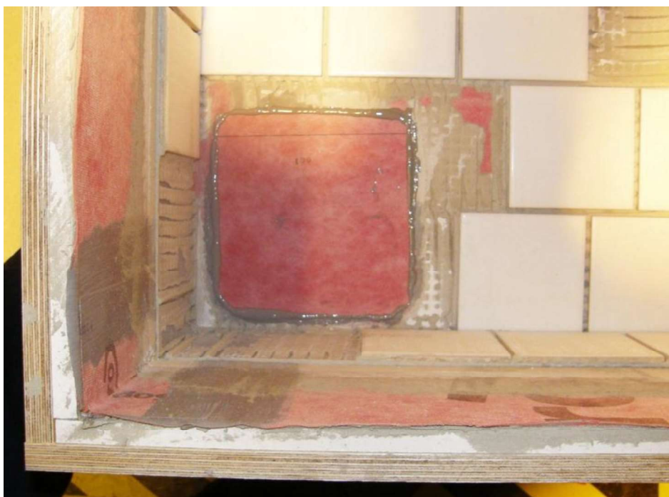
Fotografi 22. Ny folie över ytan med ett fukthärdande lim.
