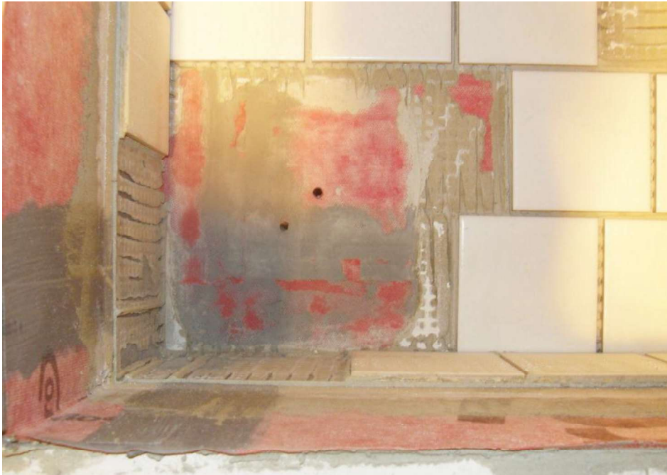
Fotografi 8. Borttagning (slipning) av fästmassa i provlåda 9.
