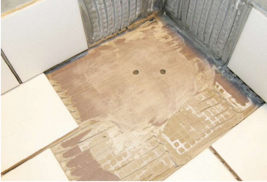
Fotografi 10. Borttagning (slipning) av fästmassa i provlåda 11.
