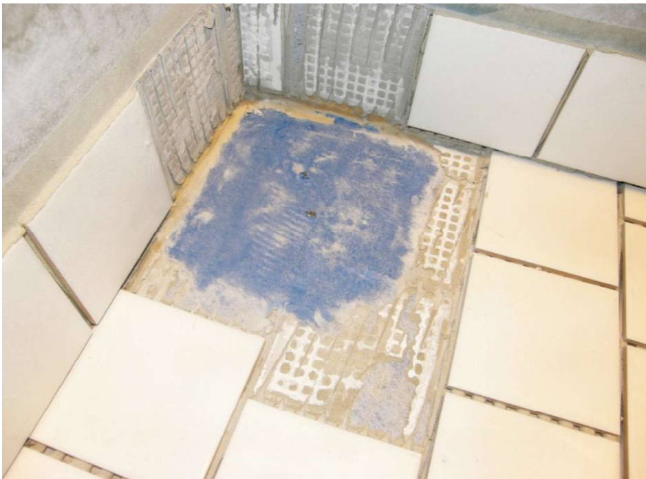
Fotografi 9. Borttagning (slipning) av fästmassa i provlåda 10.
