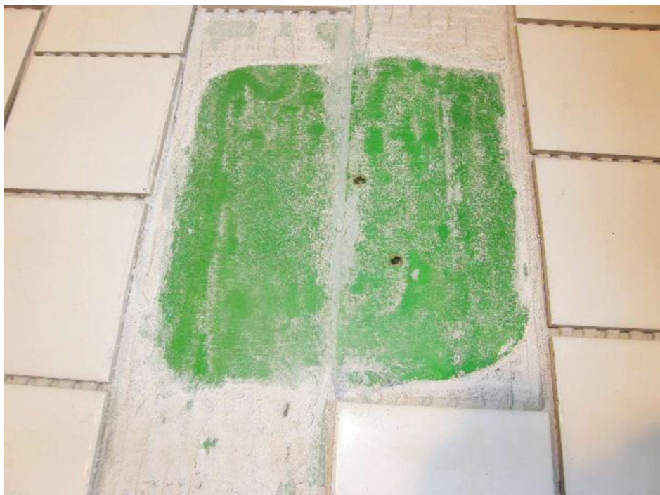
Fotografi 7. Borttagning (slipning) av fästmassa i provlåda 7.
