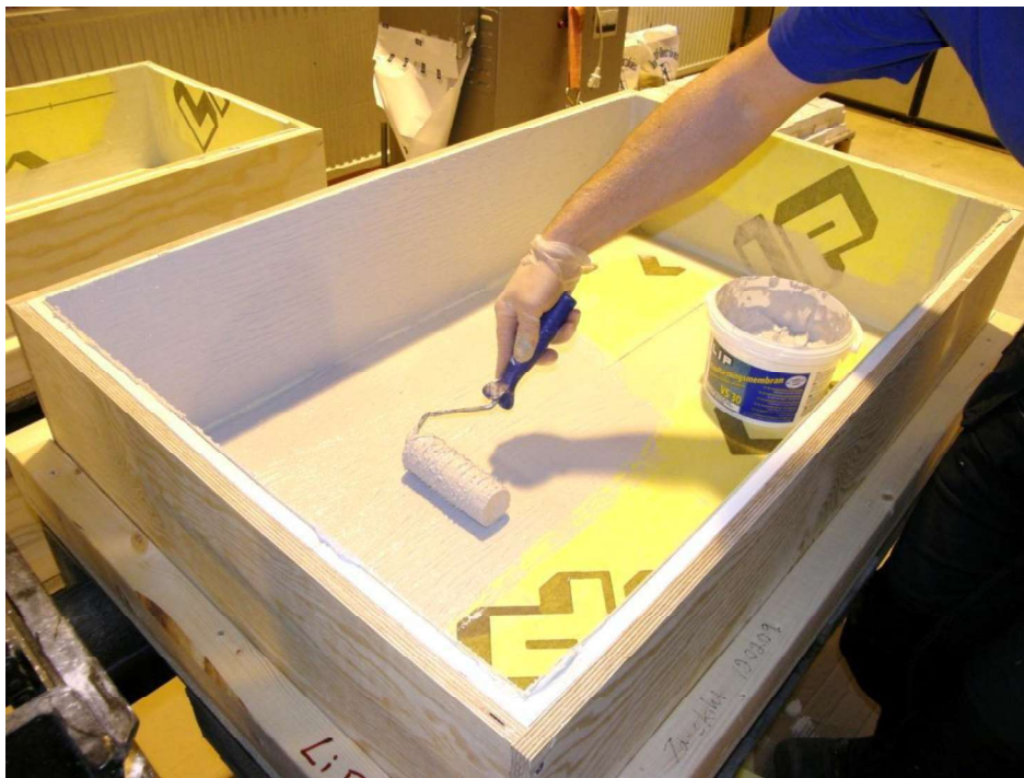
Fotografi 20. Heltäckande skikt med gummidispersion appliceras på tätskiktet.
