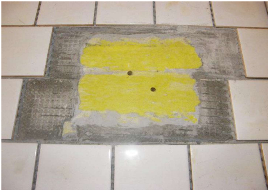
Fotografi 6. Borttagning (slipning) av fästmassa i provlåda 5.
