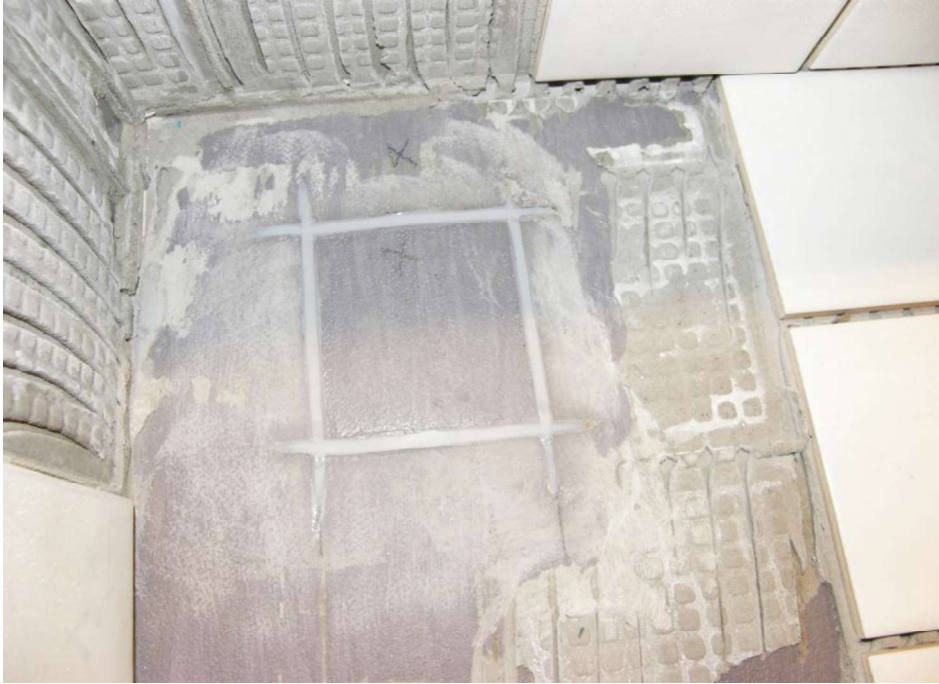
Fotografi 27. Utförd delreparation i anslutning till vägghörn.
