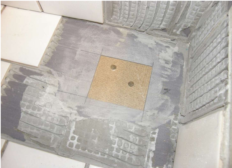
Fotografi 26. Frilagd spånskiva i anslutning till vägghörn.
