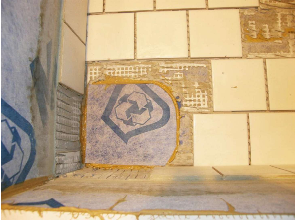
Fotografi 24. Ny folie över ytan med ett fukthärdande lim.
