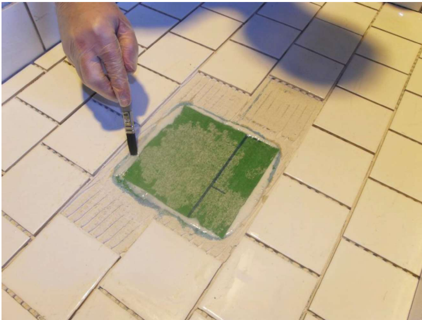
Fotografi 21. Ny folie över ytan med ett fukthärdande lim.
