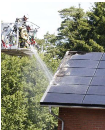
Figur 7. Brand i solcellsanläggning på villatak.
