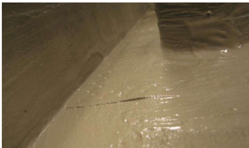
Glipa mellan rörmanschett 110 mm och golv.
