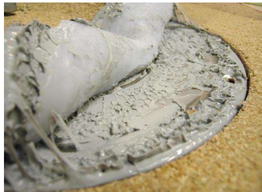
Blücherbrunnen, separation mellan brunnsmanschetten och folien.
