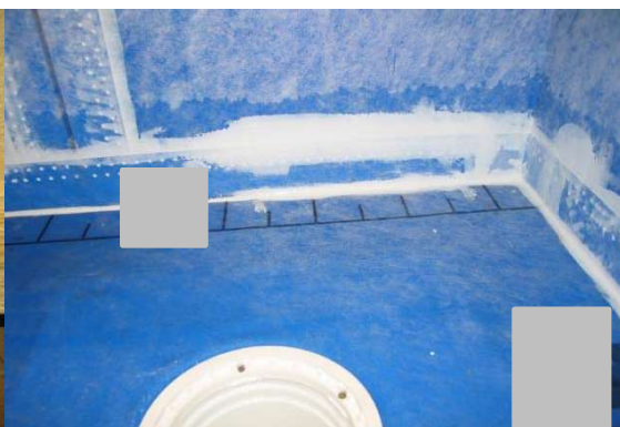
Försök till lagning med ett extra lager av produkten B kring skarvremsan i golv-väggvinkel bakom Jafobrunnen.
