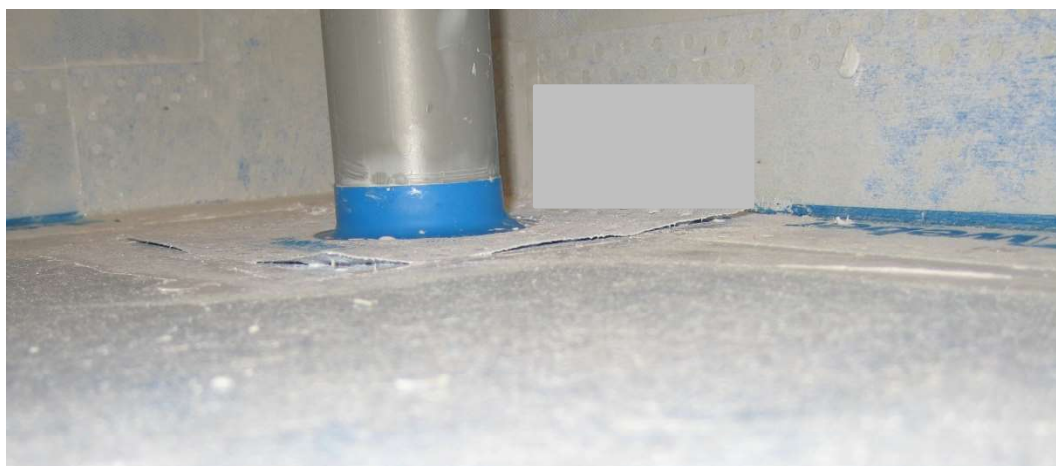
Glipa mellan rörmanschett 50 mm och golv.
