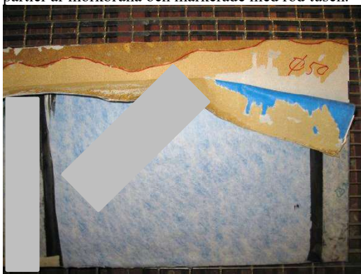
Väggparti, långsida utanför DN 50 rör.
