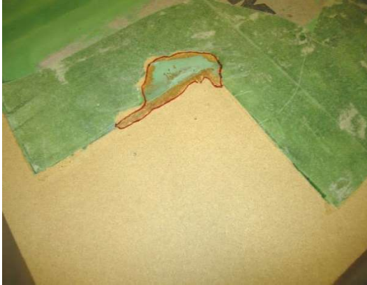
Läckage i golv vid ytterhörn (punkt 5).
