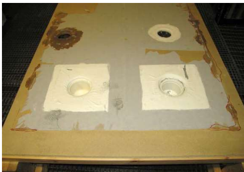
Provlådans golv efter demontering av tätskikt. Blöta partier är mörkbruna och markerade med röd tusch.
