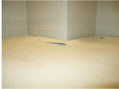
Innerhörn och ytterhörn har släppt från golvet.
