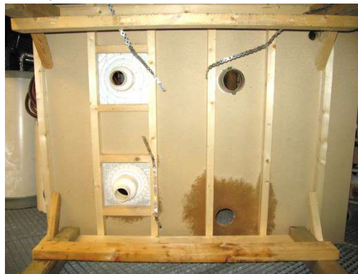
Blöta golvpartier på lådans undersida.
