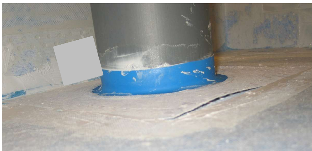
Glipa mellan rörmanschett 110 mm och golv.
